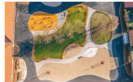
Végétalisation et désimperméabilisation de la cour de l'école E. Laguerre à Bar-le-Duc (55)
